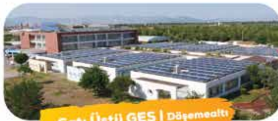
Çatı Üstü GES | Döşemealtı
