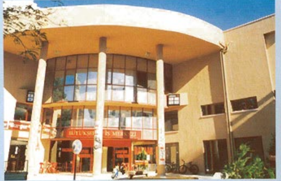
72 Falezler üstünde gelişen kent The city developing on the cliffs 73 İş merkezi girişi Entrance of a Shopping Mall
