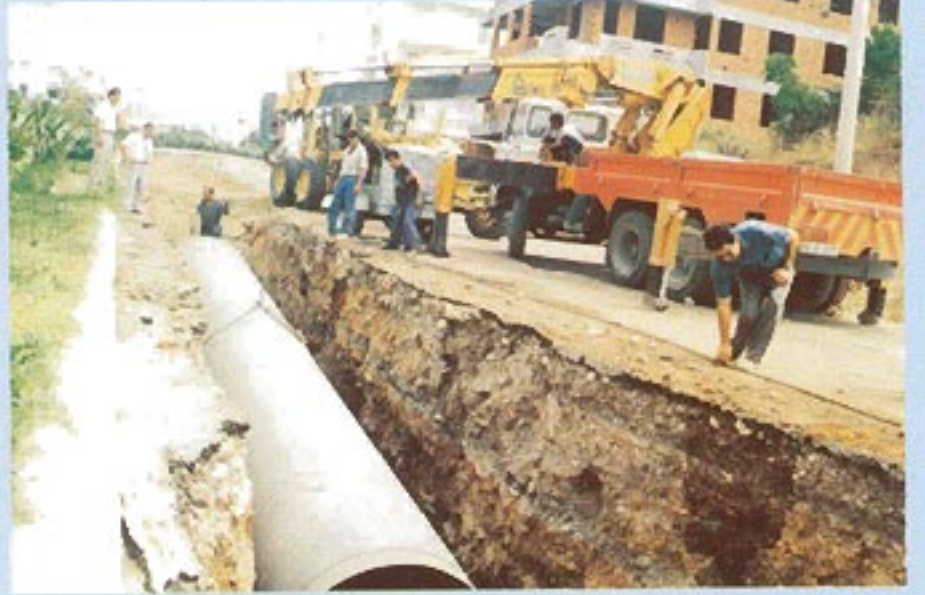
58 İşte Beydağları Beydağları 59 Altyapı çalışmaları Infrastructure works
