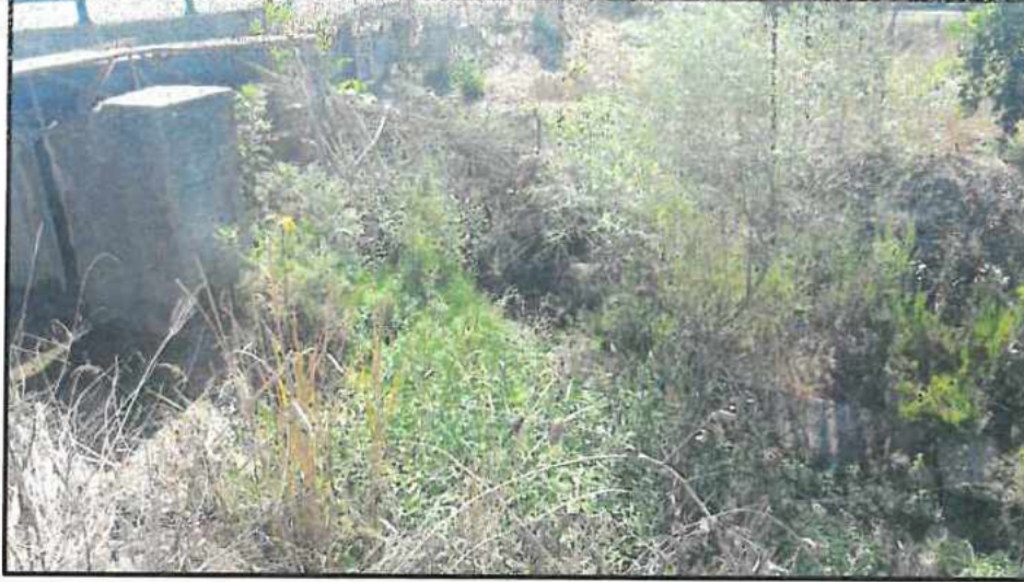
Resim 10: DSİ Su Kanalı İçinde Görülen Yapı Kalıntısı-2
